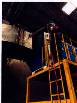
5#喷漆废气处理前采样口 (FQ-39209-6)
