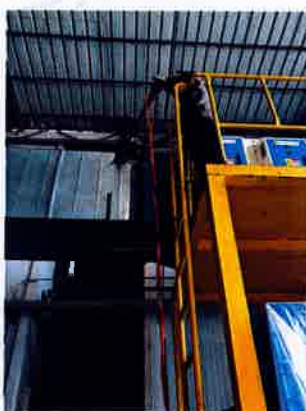
2#喷漆废气排放口 (FQ-39209-4)
